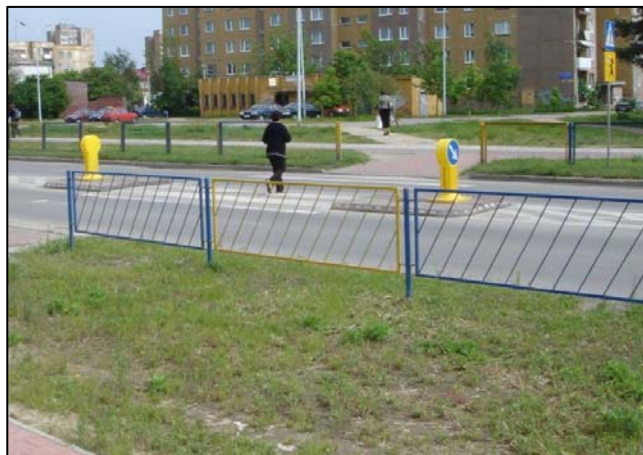
Zdj. 2. Wygradzenie przy przejściu dla pieszych
