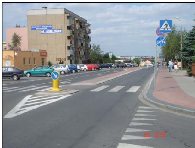
Zdj. 1. Azyl z wyniesionym pasem rozdziela i wydzielonym pasem do skrętu w lewo
