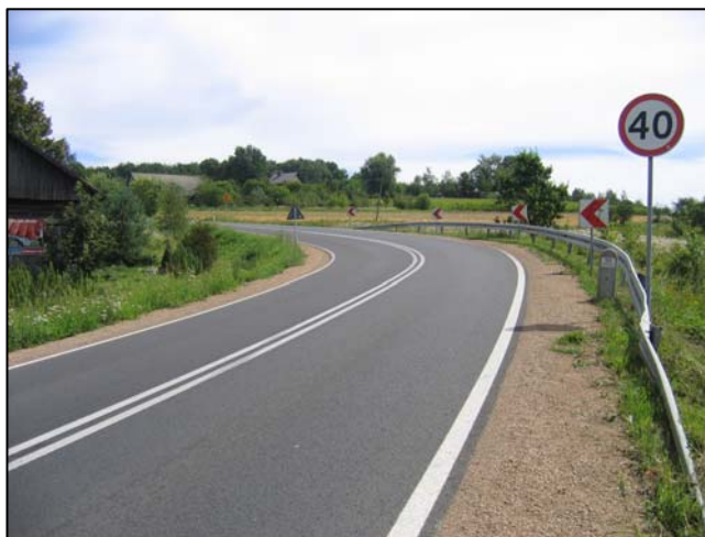
Zdj. 9. Zabezpieczenie ostrego zakrętu
