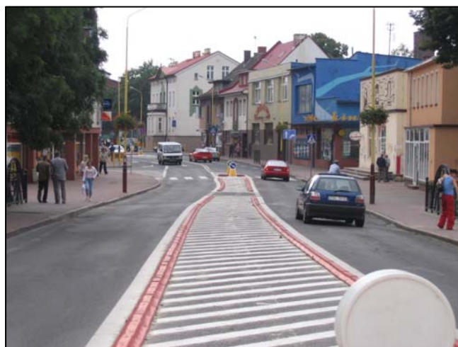
Zdj. 3. Wyniesione elementy kanalizujące ruch
